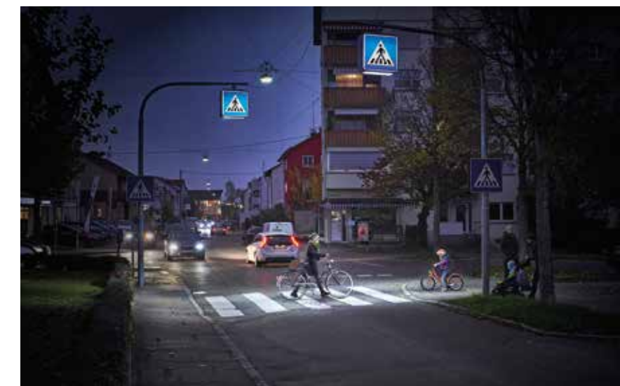
Sicherer Fußgängerüberweg mit LED-Technik in der Bruckstraße in Fellbach
